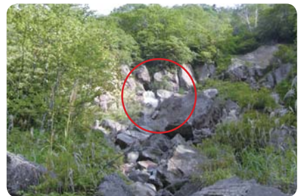
④白糸の滝左岸の坑内排水口
